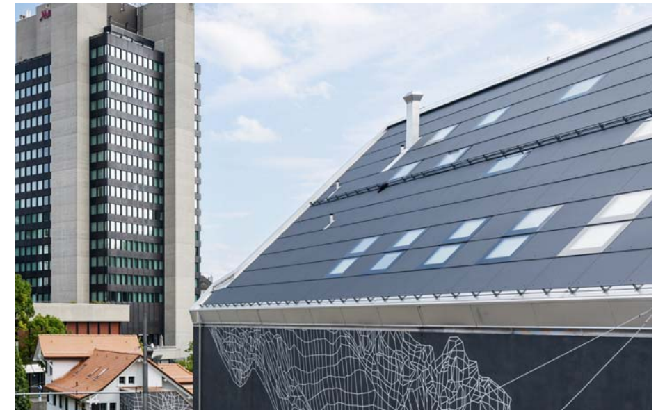
Maison de la culture Dynamo, Zurich/Suisse, Architecture: Kaufmann Widrig Architekten GmbH, Zurich
