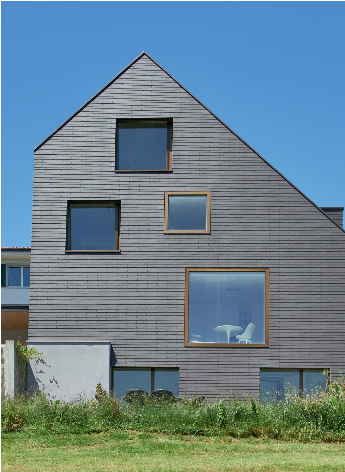
Maison individuelle, Dättikon/Suisse, Architecture: Weiss und Schmid Architekten, Winterthur
