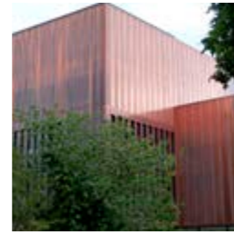
Landeskirchliches Archiv, Nürnberg Außenwände aus einer matt schimmernden Kupferfassade mit feiner, vertikaler Gliederung
