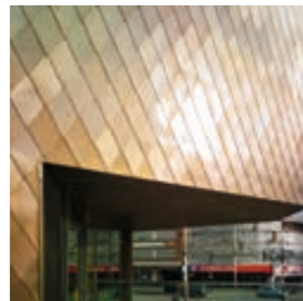
Metallfassade mit individueller Positiv-/Negativprägung, die vielfältigste Lichtreflexionen erzeugt.
