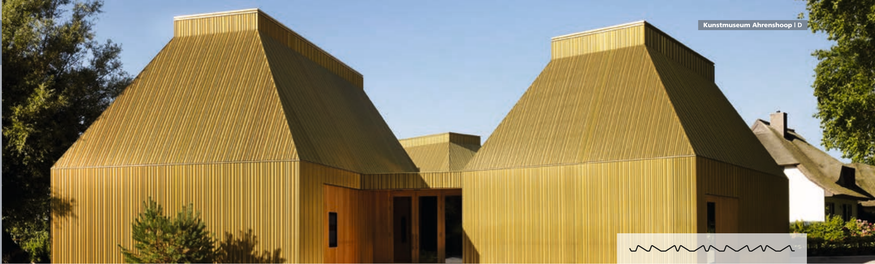
unregelmäßiges Zickzack-Profil SZ-25/50-R, gespiegelt, Messing
