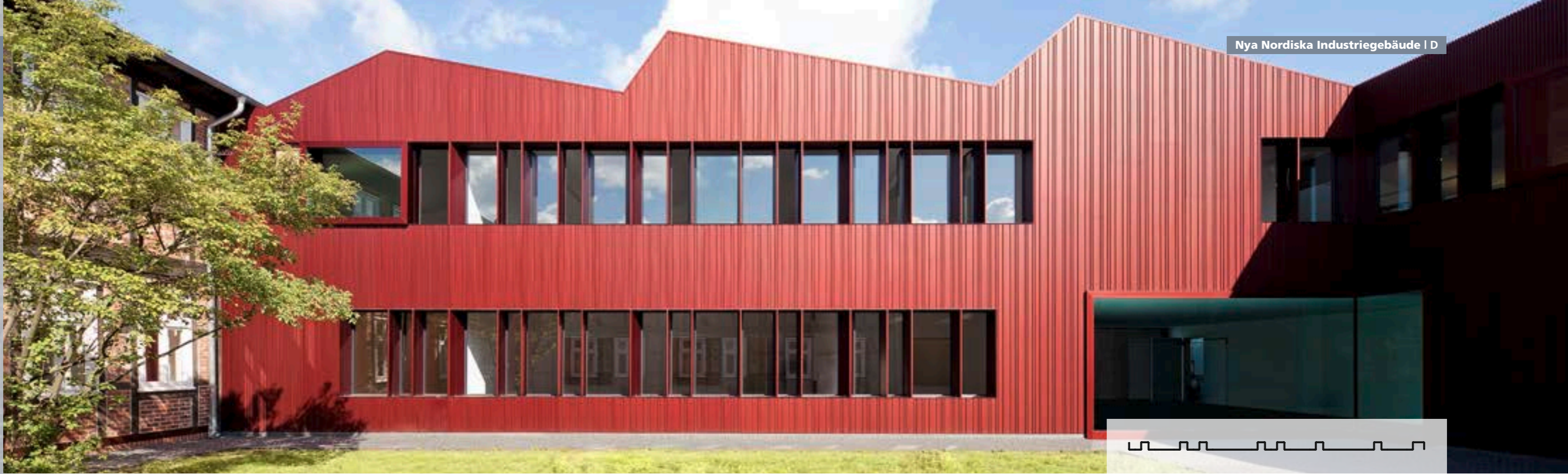
Unregelmäßiges Sonderprofil SQ-20/20-R, AlMg1, Sandalor® eloxiert
