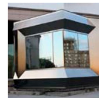
Kulneva, Moskau Ausgangsmaterial 2.000 mm Breite, wurde zur Hälfte in Champagner und in Schwarz in Polyspektralverfahren gefärbt, in einem Stück gekantet und hinterfräst, um einen möglichst geringen Kantradius zu erhalten.
