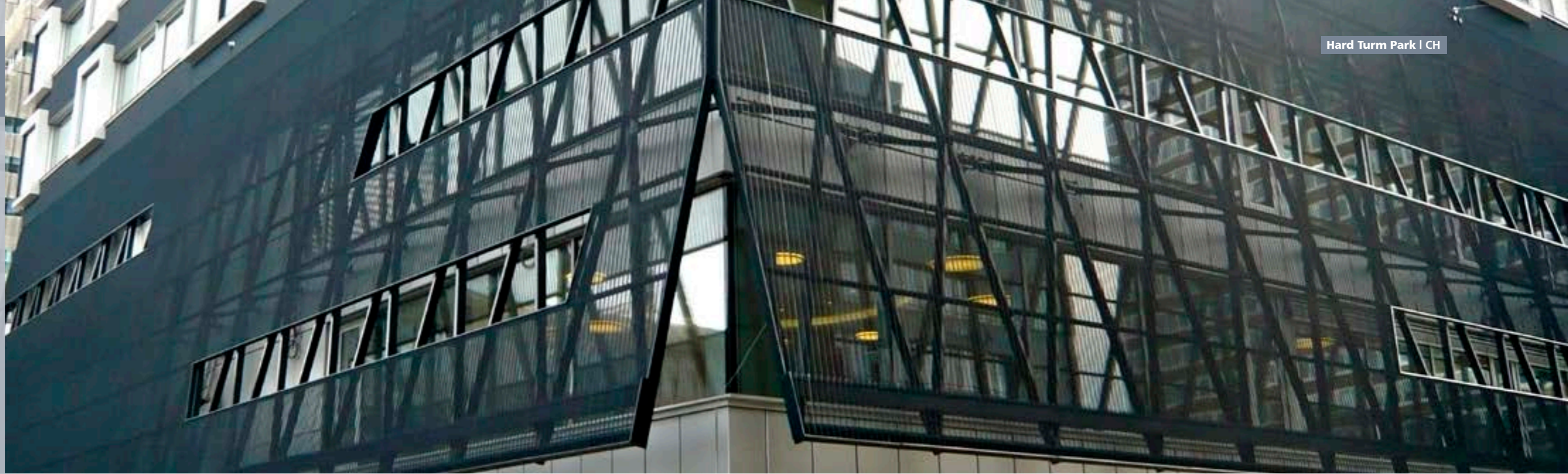
Profil SZ-30/60 R75 (Stärke: 1,5 mm), Aluminium, gelocht, RV3-4 sowie ungelocht. Das Röckli dient zudem als Sonnenschutz.
