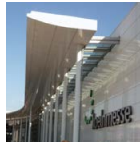
Neue Kölner Messehallen: Verkleidung mit einer hochwertigen Polyesterbeschichtung AlMg
