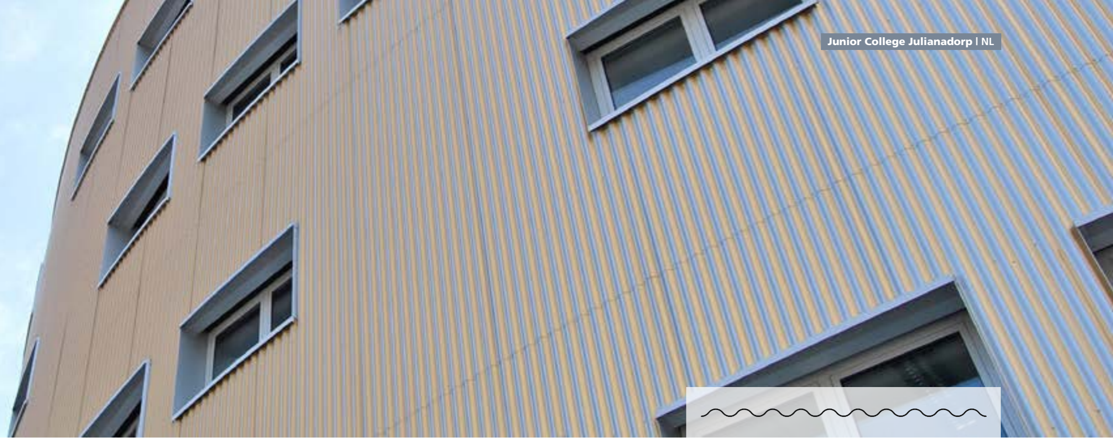
wellTEC® W-27/100, AlMg1, zweifarbig lackiert
