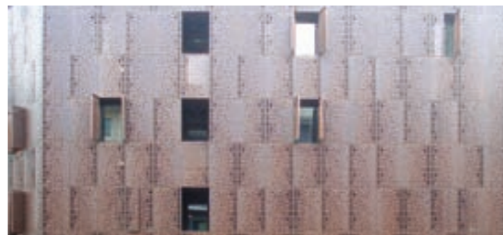
Fensterläden/Sonnenschutz aus Lochblech
